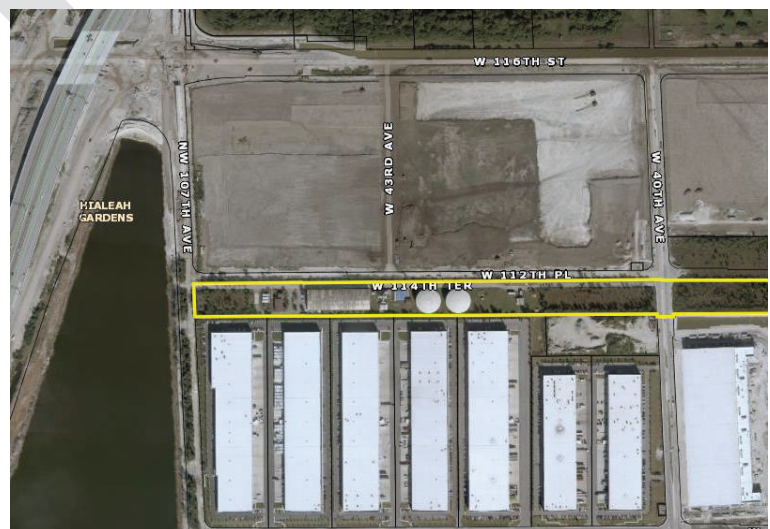
Hialeah RO WTP (Courtesy MDPA)
