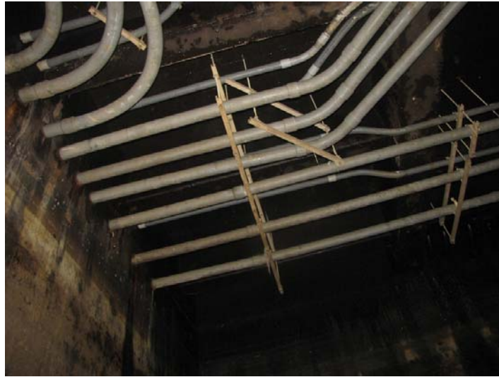
Photo #12. Electrical conduits
